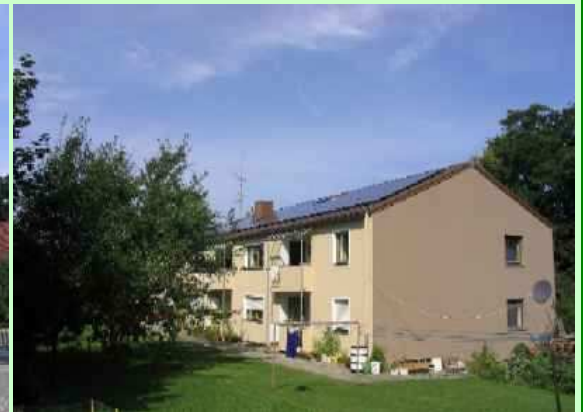
Die Fotos zeigen die beiden Dachflächen mit den installierten Solarmodulen. Die Modulfläche beträgt etwa 330m².
